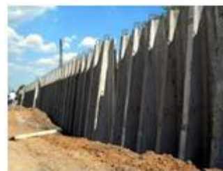
OPERE DI SOSTEGNO IN C.A.
