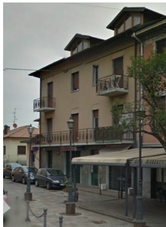
Sedime e volume originario con introduzione di vani di porte e finestre fuori modulo, introduzione di oscuranti estranei a quelli originari, parapetti, abbaini e materiali di facciata non congrui
