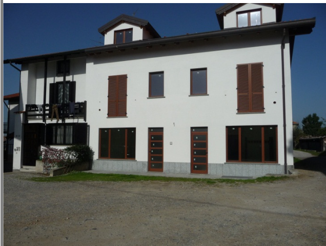
Pur mantenendo il sedime originario i volumi risultano modificati
