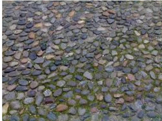
Esempi di rizzata, anche con posa di lastre in pietra, decorative o per formazione carrarecce.
