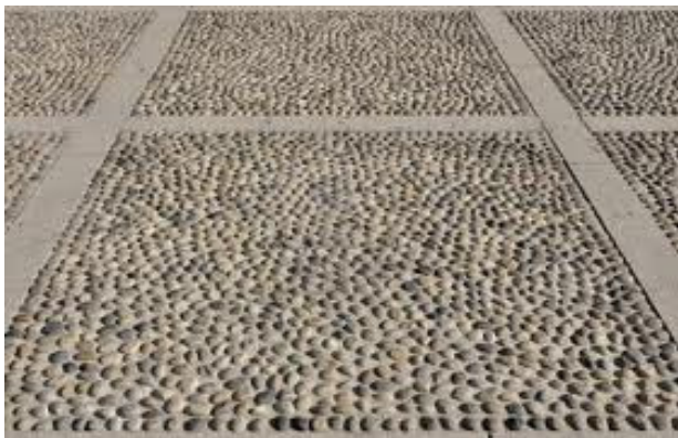
Esempi di rizzata, anche con posa di lastre in pietra, decorative o per formazione carrarecce.
