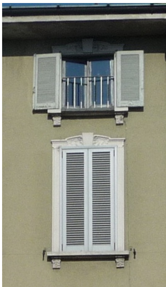
Esempio di rapporto tra finestra del piano abitabile e francesina di illuminazione del piano sottotetto – Finestre con modanature neoclassiche e oscuranti a persiana
