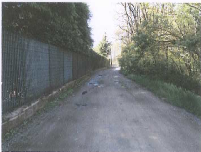
Foto 13: Consorziale della Livescia (asse sud)
