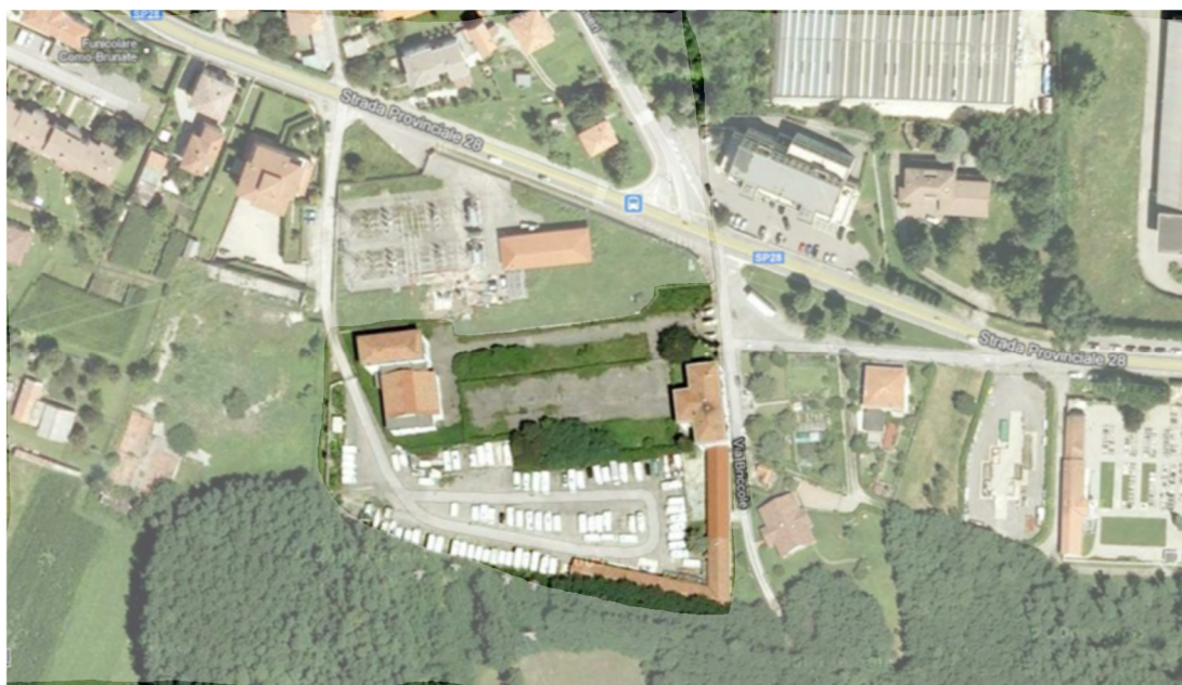
Vista da satellite dell'ex sedime della centrale di trasformazione ENEL
